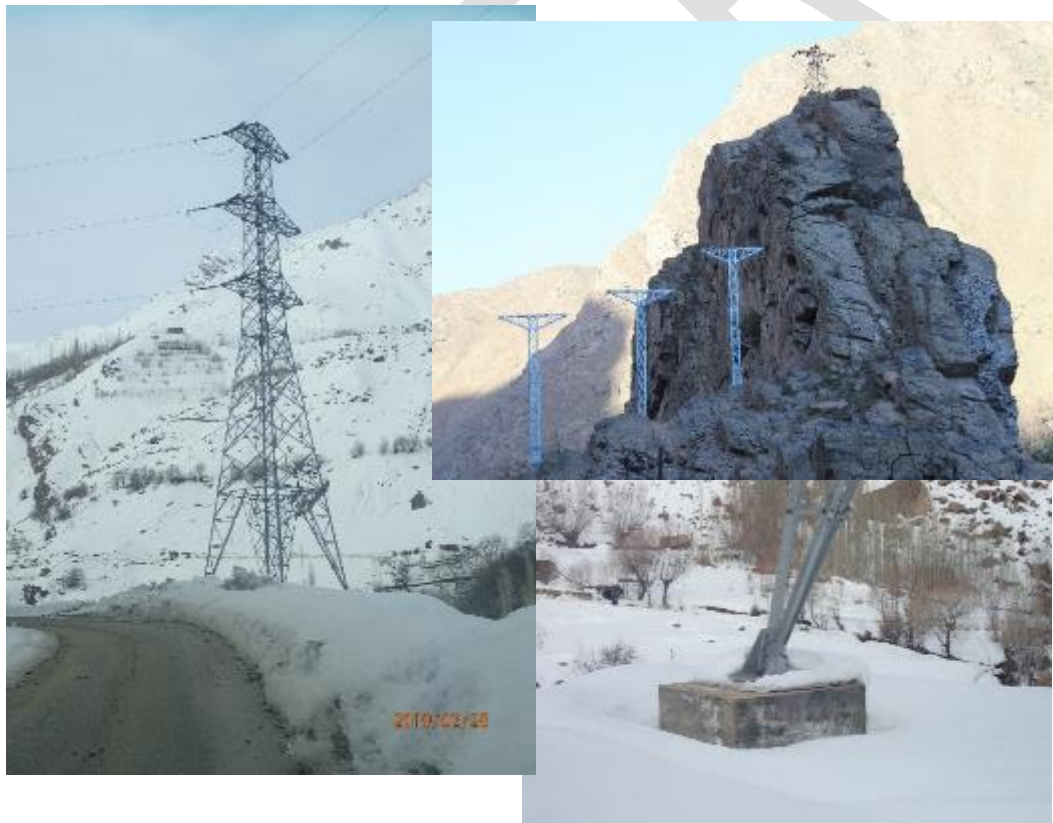
Рисунок 5. Примеры башен: угловая башня слева, три опорных стойки на неровной поверхности справа вверху, пример фундамента справа внизу
